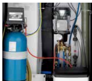
Langlebige Technik Wasserenthärtungsanlagen beugen Kalkablagerungen vor und garantieren die Langlebigkeit der Anlage.
