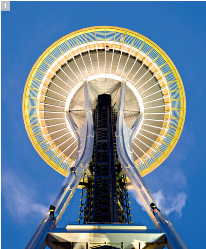
1 Het hoogste gebouw van Seattle – de Space Needle Met hoge druk voerde het Kärcher-team reinigingswerkzaamheden uit op een hoogte van 184 m. 8 weken lang – en alleen 's nachts.
