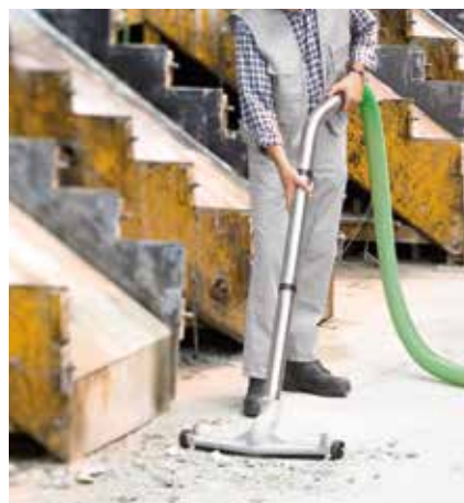
Изсмукване на минерални остатъци, напр. бетон
