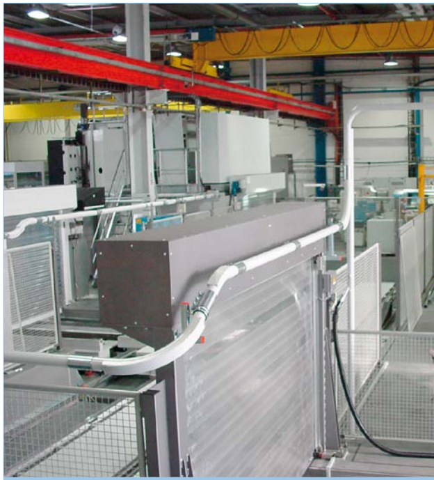
● Saugstelle mit Schwenkarm und Rohrleitung
