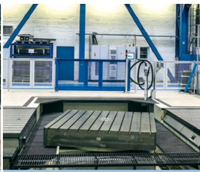
Ausgelagerte Saugstelle für großflächige Zerspanungsplätze
