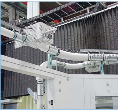
● Rohrleitungssystem mit elektropneumatischem Schieber und elektrischen Steuereinheiten
