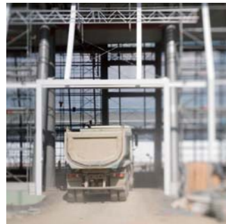
建設作業現場
