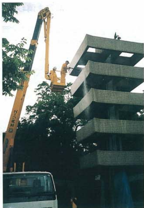
高さ12mのモニュメントは高所作業車を使用しました。
