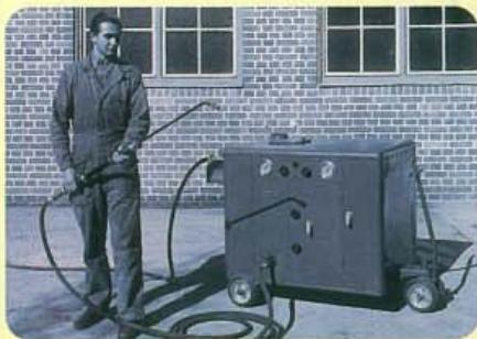
●ヨーロッパ初の高温高圧洗浄機 KW 350
