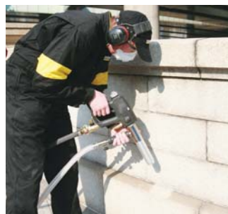
パウダーを空気で吹き付けるパウダー洗浄
