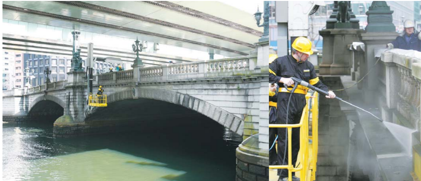
外壁を高所作業車にて視察
