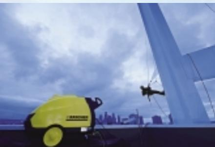
作業に使用した業務用温水高压洗浄機
