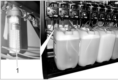
1 Filtro de la bomba de protección antiheladas
