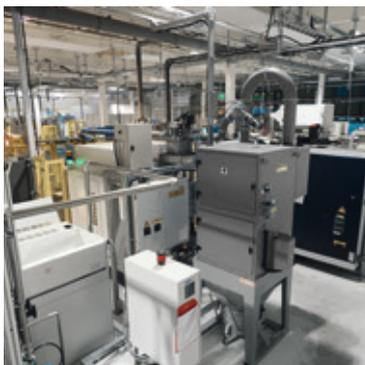
Rohrleitungen für Industrieentstauber erlauben die Installation weiter Saugstrecken, sodass Industrieentstauber nicht direkt an der Saugstelle platziert werden müssen. Außerdem ermöglichen sie die Anbindung mehrerer Absaugstellen an einen Entstauber.
