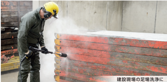
建設現場の足場洗浄に
