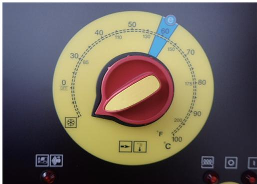
温度設定スイッチを凍結防止モードに合わせる。
