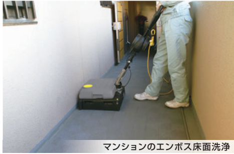
マンションのエンボス床面洗浄
