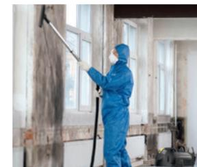
**微細粉塵対応** 解体工事の現場にセーフティフィルターバックやエコフィルター (HEPA)、シールキャップなど、密閉性と排気をクリーンにする仕様が標準装備です。作業、保管時の粉塵漏れを抑えて、作業者の安全を確保します。
