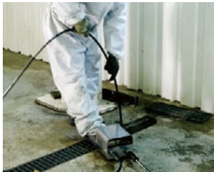
パイプクリーニング
