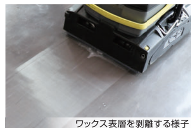
ワックス表層を剥離する様子
