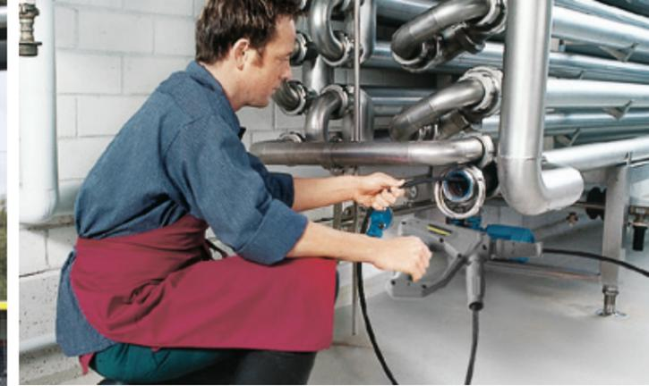
**Spezialzubehör zur Rohrreinigung** Reinigen Sie verschmutzte oder verstopfte Abflüsse und Rohre im Handumdrehen. Die nach hinten gerichteten Düsenöffnungen ziehen den Schlauch automatisch ins Rohr. Selbst hartnäckige Ablagerungen werden zuverlässig gelöst und mit dem Wasserstrom aus dem Rohr geschwemmt. Unsere besonders kraftvollen Rohrreinigungsdruckfräser arbeiten sich mit ihrem nach vorn gerichteten rotierenden Punktstrahl zuverlässig durch hartnäckigste Verstopfungen.
