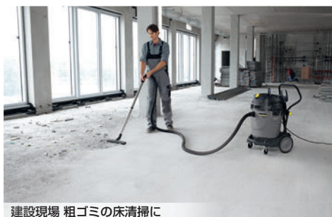
建設現場 粗ゴミの床清掃に
