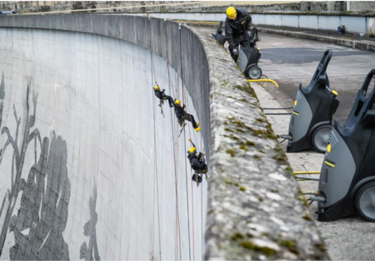
Vier professionelle Kaltwasser-Hochdruckreiner wurden eingesetzt; gespeist wurden sie aus dem See, der Strom kam vom dortigen Kraftwerk.
