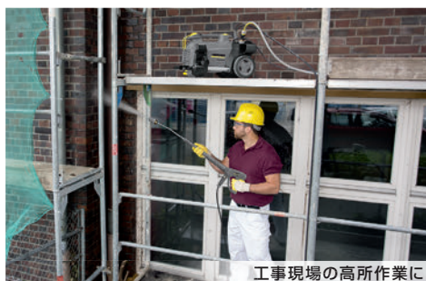
工事現場の高所作業に
