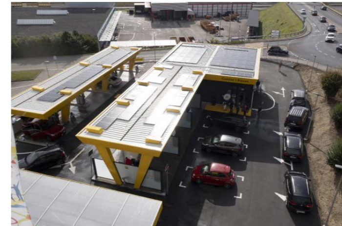
Der gesamte Strombedarf der Anlage wird durch Sonnenkollektoren gedeckt.
