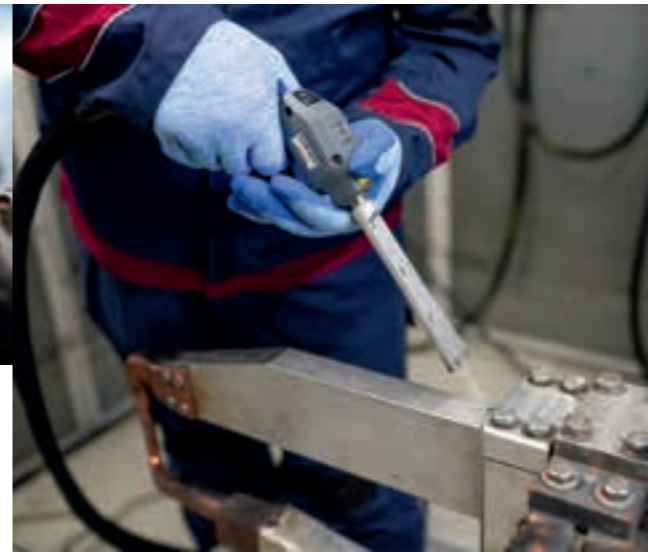
Voordat onderhoud wordt uitgevoerd, wordt droogijs gebruikt om ter plaatse snel en zorgvuldig te reinigen.
