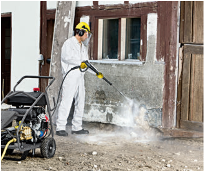
コンクリートの削り作業に
