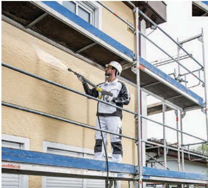
建物の外壁洗浄に
