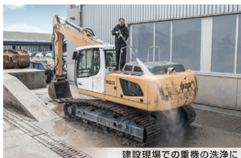
建設現場での重機の洗浄に
