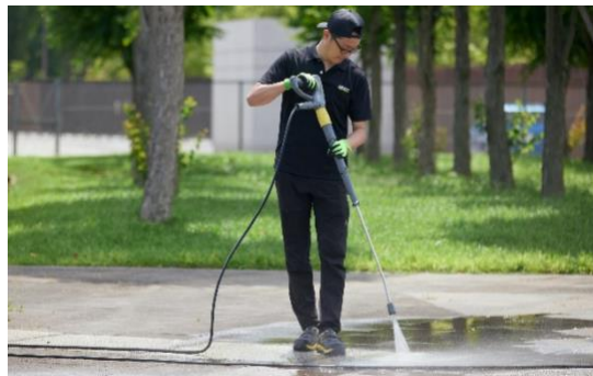
業務用高圧洗浄機や家庭用上位モデルを使って広場舗装面の黒ずみを洗浄
