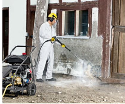
コンクリートの削り作業に
