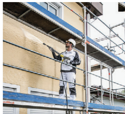
建物の外壁洗浄に
