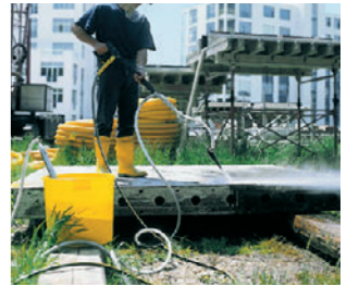
サンドブラストキット 土木建築資材のコンクリートパネルの洗浄に。
