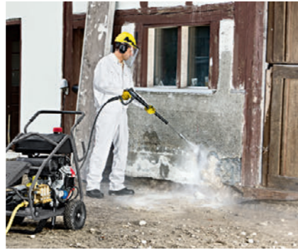
コンクリートの削り作業に
