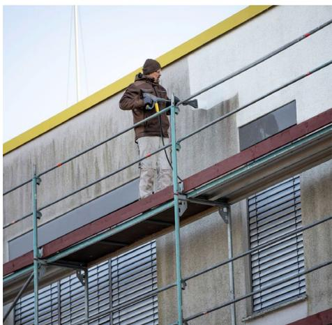
*Grâce à la nouvelle buse, il est possible d'éliminer les salissures de faible à moyenne intensité, y compris sur les surfaces délicates comme lors du nettoyage des façades...*
