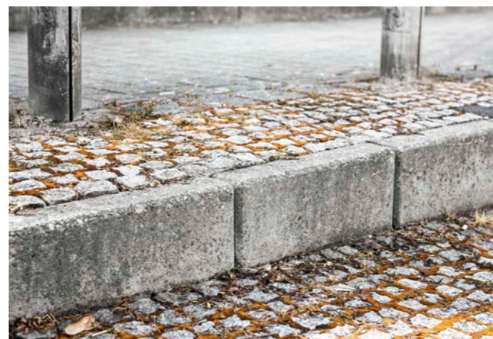
Nach der Anwendung von Heißwasser Eine Woche nach der Behandlung mit Heißwasser ist das Unkraut abgestorben und Gräser sind durch die Wittereinflüsse bereits größtenteils abgetragen.
