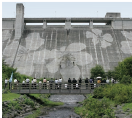
栃木県・松田川ダム／2008年
