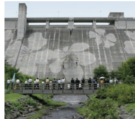
栃木県・松田川ダム／2008年
