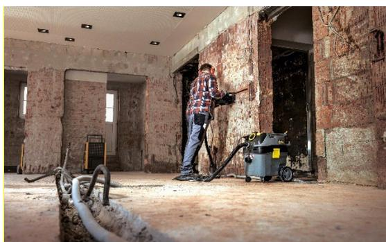
*En plus de la certification intégrale pour les classes de poussière M ou H, ces aspirateurs eau et poussières disposent d'un câble en caoutchouc à trois fils pour l'utilisation au chantier ainsi que d'un système antistatique avec des accessoires électroconducteurs.*
