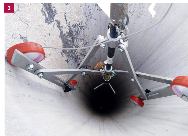
1 2 Der EcoMaster D 250M Classic mit einem Betriebsdruck von bis zu 3.000 bar bietet die benötigte Leistung für den Abtrag von Beton und Beschichtungen.
