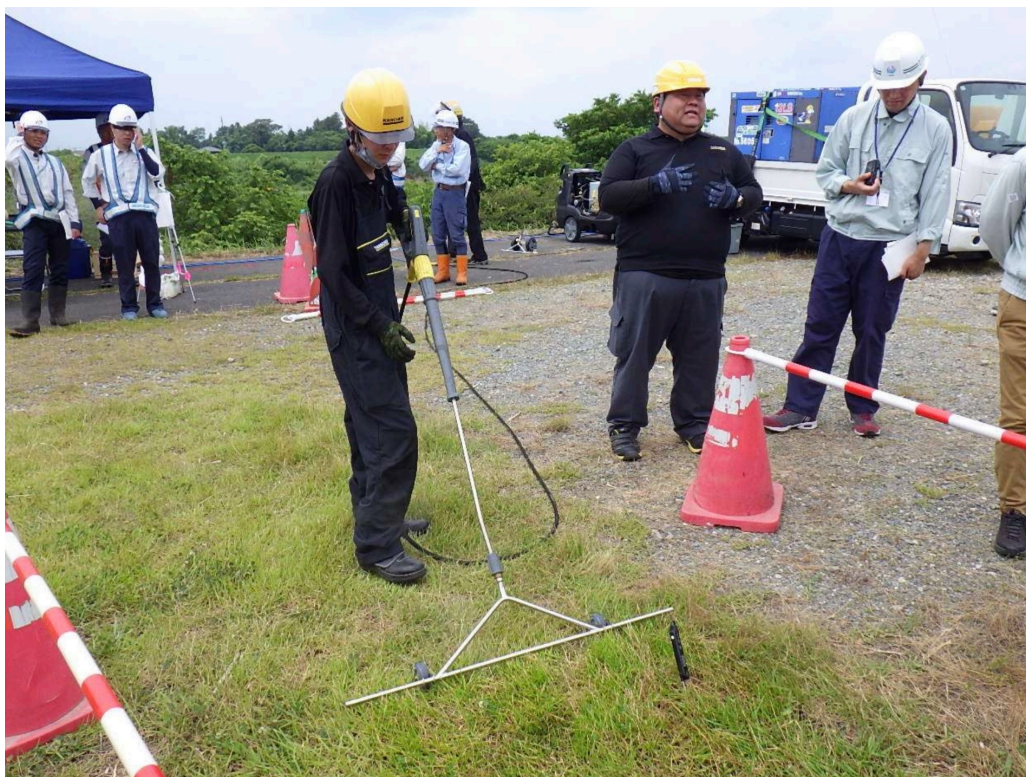
温水除草システム ® の試験施工の様子
