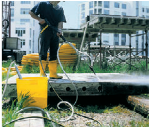
サンドブラストキット 土木建築資材のコンクリートパネルの洗浄に。
