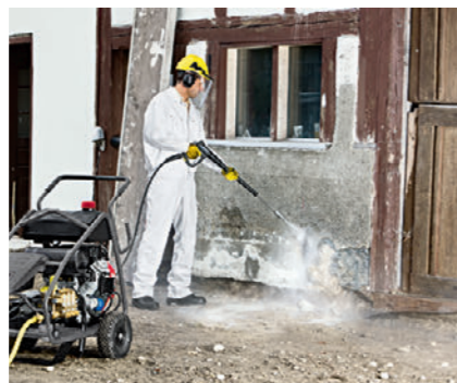
コンクリートの削り作業に
