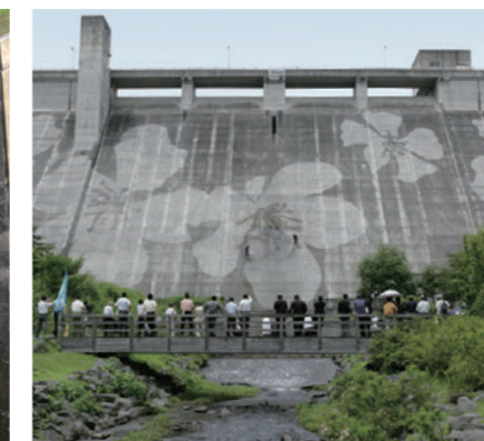
栃木県・松田川ダム／2008年
