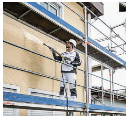
建物の外壁洗浄に
