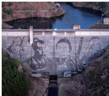
栃木県・松田川ダム／2026年
