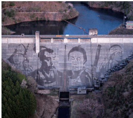
栃木県・松田川ダム／2026年
