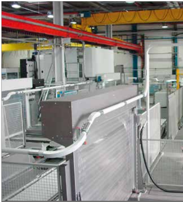
● Poste d'aspiration avec bras pivotant et tuyauterie
