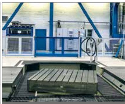
Point d'aspiration décentralisé pour de postes d'usinage d'envergure
