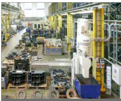
Station d'aspiration centrale en guise de système multipostes dans l'industrie métallurgique
