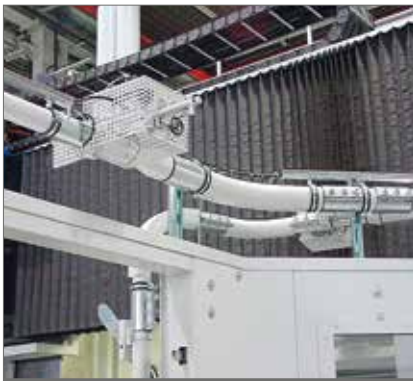
● Système de tuyauterie avec soupape électropneumatique et unités de commande électriques
