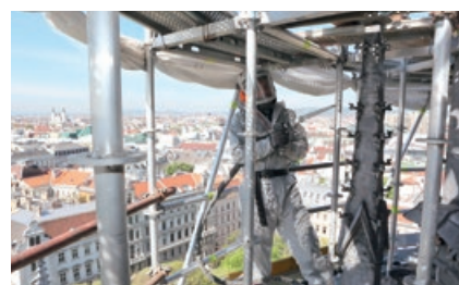
(写真上) ニューヨークのグリーンウッド墓地 (写真中) 長年蓄積した汚れを注意深く洗淨 (写真下左) ウィーンのヴォーティーフ教会 (写真下右) ドライアイスブラスターで 教会の尖塔を洗淨
