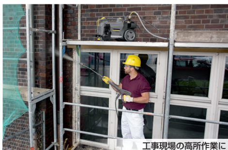
工事現場の高所作業に
