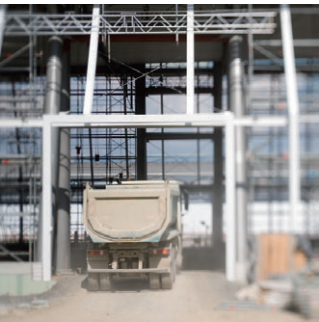
建設作業現場
