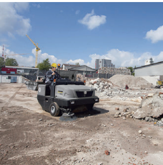
産廃・リサイクル工場
