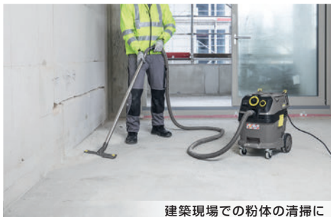
建築現場での粉体の清掃に
